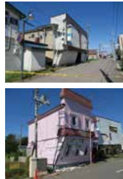
むかわ町被災建物
