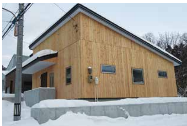
写真1 北総研防火木外壁の適用物件
