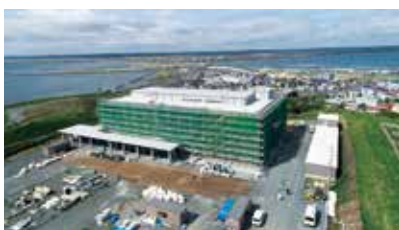
④ 躯体工事完了
