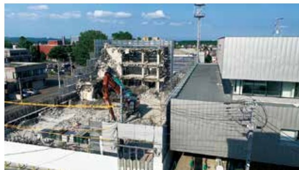
解体中の第1庁舎
