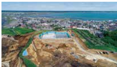
② 免振ピット施工状況
