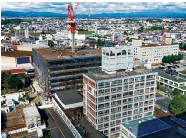
▲建設中の旭川市庁舎(奥)と現庁舎(手前)
