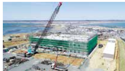
③ 躯体工事施工状況
