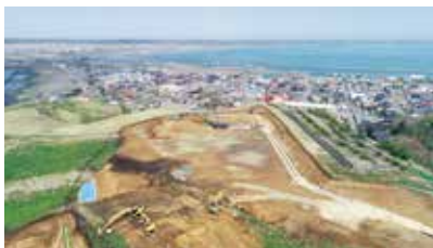
① 工事着手（庁舎敷地の造成完了後）
