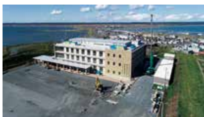
⑤ 外部足場解体・外部工事完了
