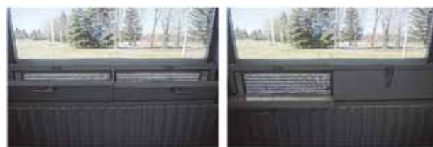
(a) 開度半分 (b) 開放個数半分 図7 開放率50%の例
