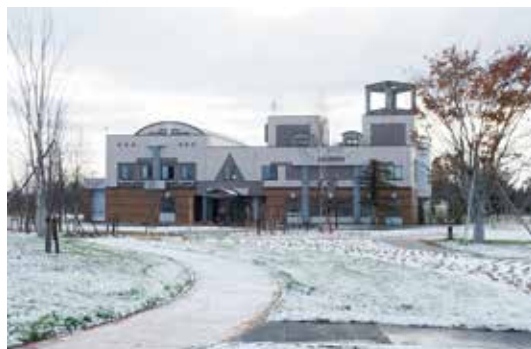
センターハウス (旧保健センター)
