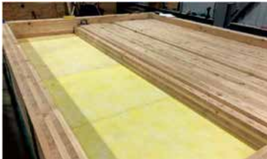
写真2 CLT浮き床工法の施工状況
