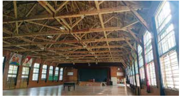
増毛小学校 体育館の木造トラス
