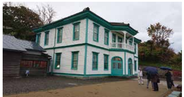
旧檜山爾志郡役所庁舎
