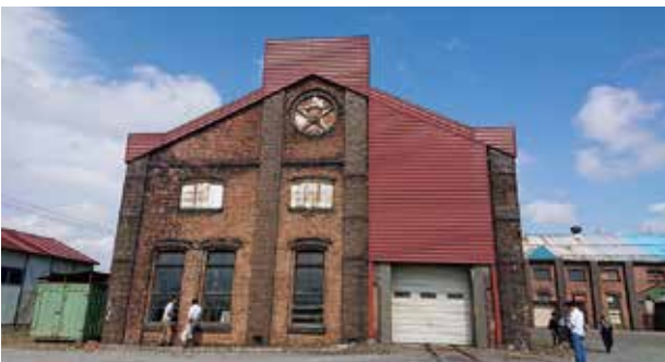
岩見沢レールセンター
