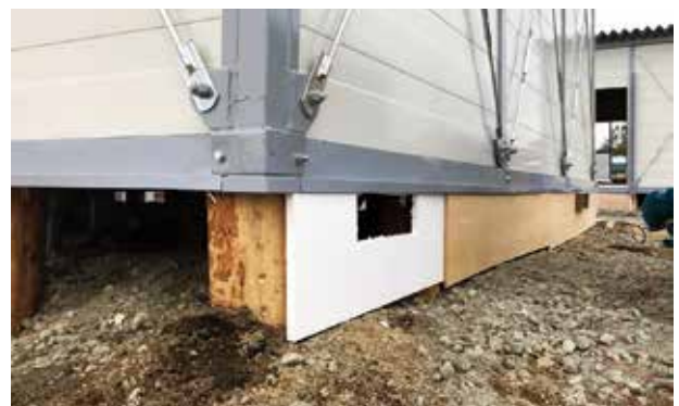
写真3 簡易基礎断熱工法の導入
