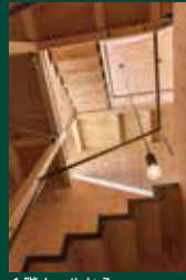
1階ホールから 上部3層吹抜けを見上げる
