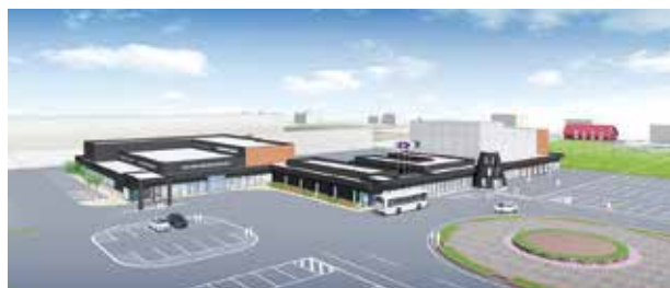
役場新庁舎はオール町産材を使用
