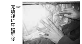
写真2 気流止め用の断熱材
