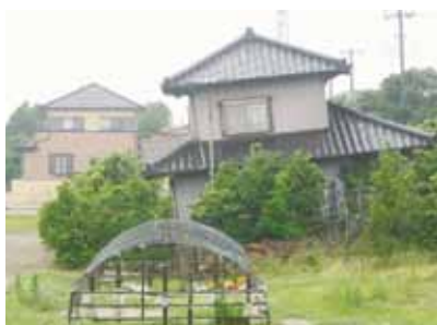
液状化による傾斜住宅（神栖市）
