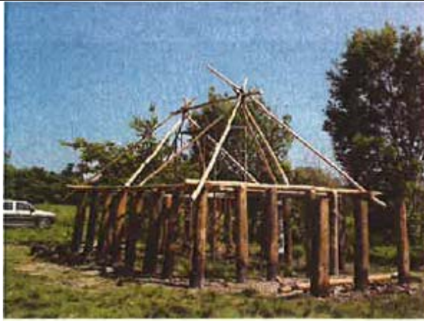
2001.6.24 両端に三脚構造
