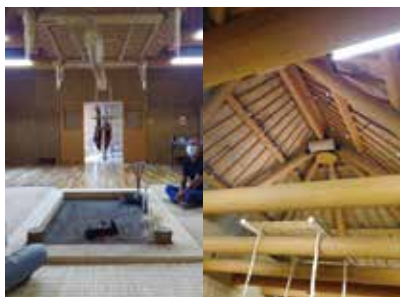
室内は仕切がなく 立派な 広いスペース 小屋組みです
