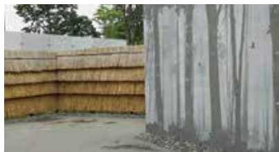
森が描かれたコンクリートの廊下
