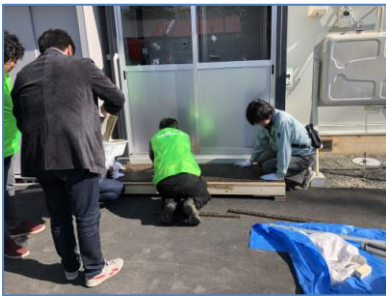
青年建築士による作業状況
