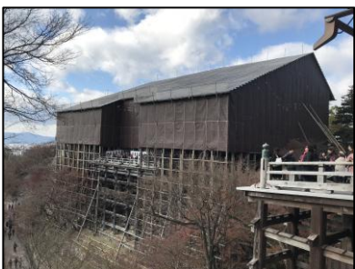
清水寺＝工事のため足場で覆われている
